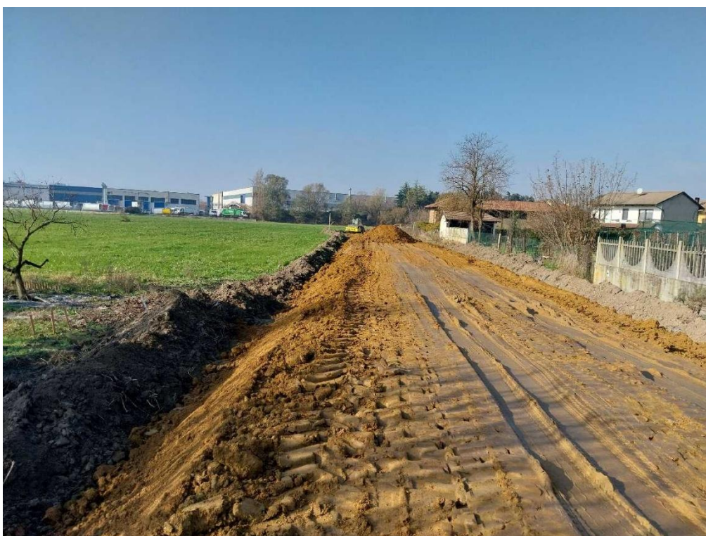
Realizzazione argine – fase di cantiere (fase 1).
