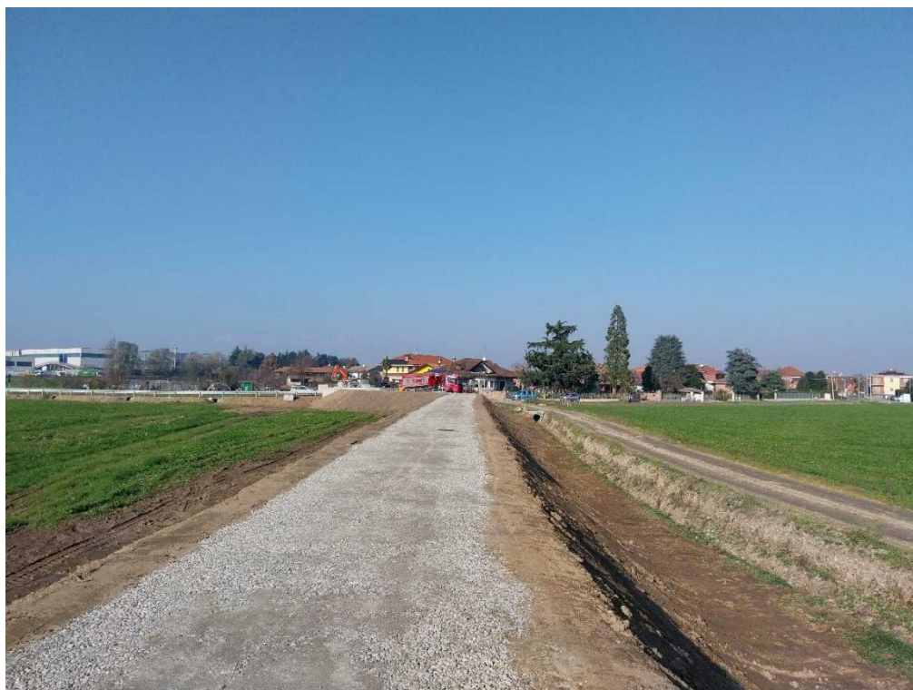
Vista argine post stesura terreno di scotico su scarpate (fase 2).
